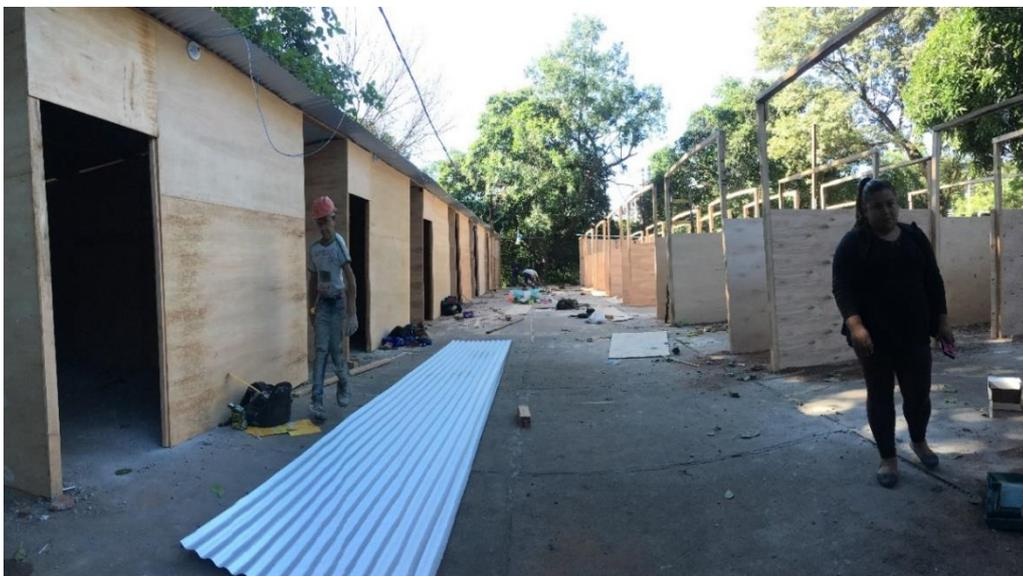
**Fotografía 19. Construcción de las viviendas de emergencia**
